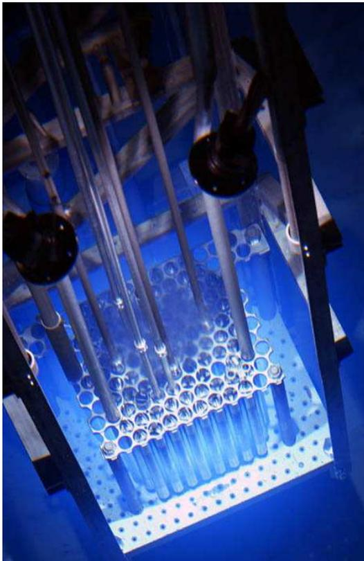
Das Čerenkov-Licht kann in Lagertanks bei Kernkraftwerken besonders schön beobachtet werden. Die von den Brennstäben emittierte Strahlung ist schneller als die Phasengeschwindigkeit von Licht in Wasser, also schneller als  $ca. 0.75 \cdot c$  und deshalb ist Čerenkov-Strahlung zu sehen. Das Bild stammt vom US-DOE.
